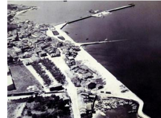
Peirao das obras- Rianxo
